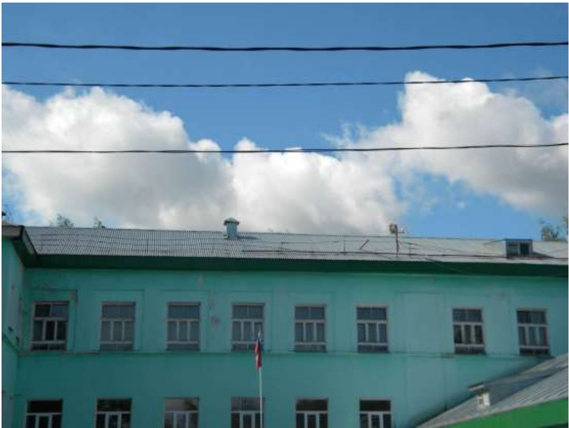
Фото №3 - Общий вид крыши
