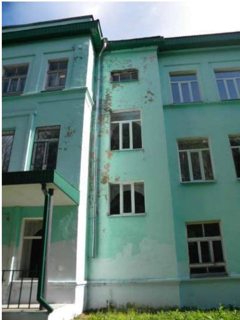
Фото №9 – Общий вид наружной стены лестничной клетки №2
