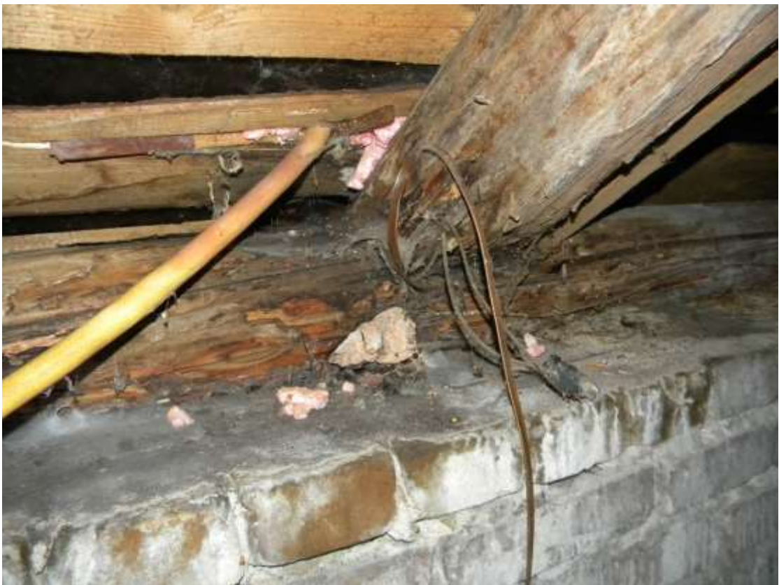
Фото №31 – Проход через кровлю инженерных коммуникаций
