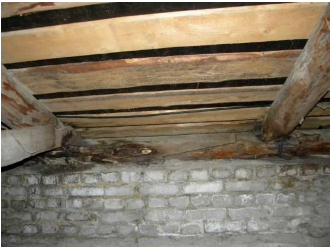
Фото №25 - Общий вид конструкций крыши
