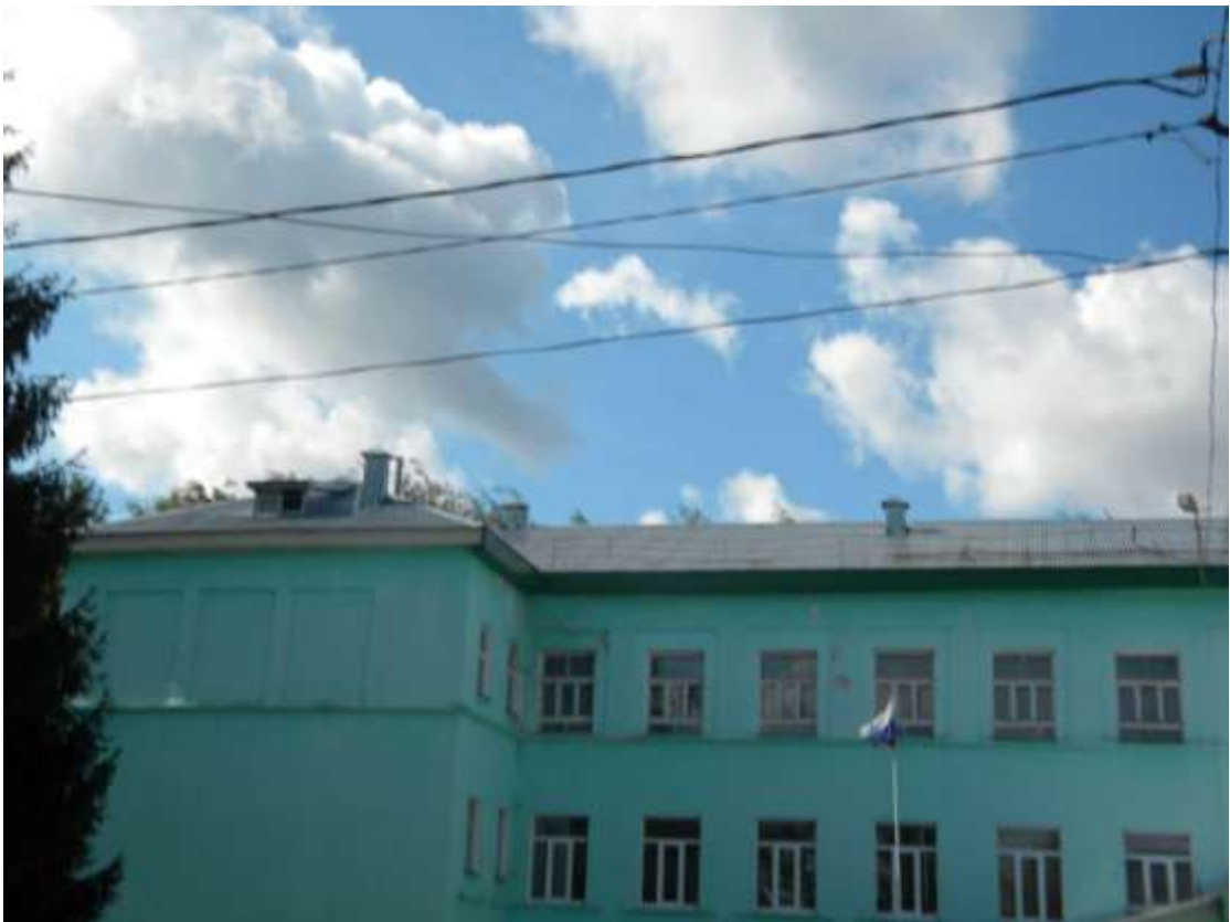
Фото №2 - Общий вид крыши
