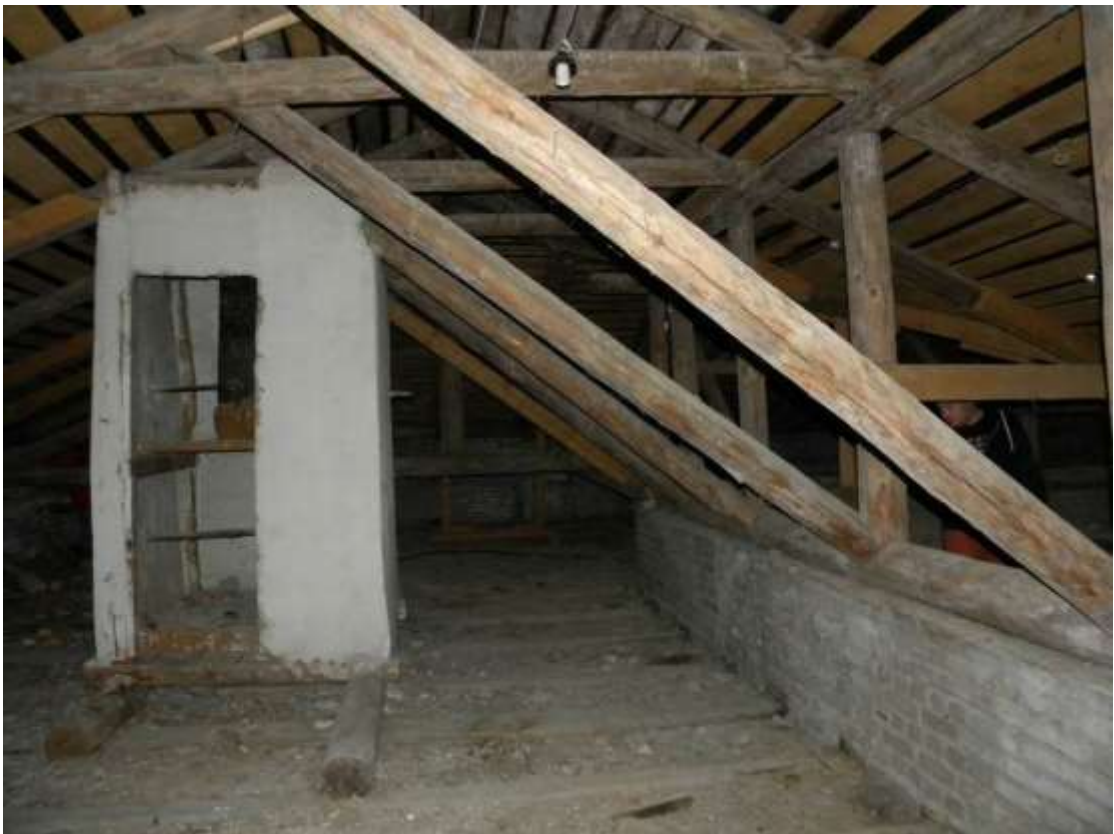
Фото №24 - Общий вид конструкций крыши
