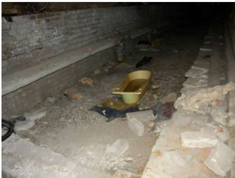
Фото №19 – Решение протечек покрытия собственными силами работников школы интернат №2
