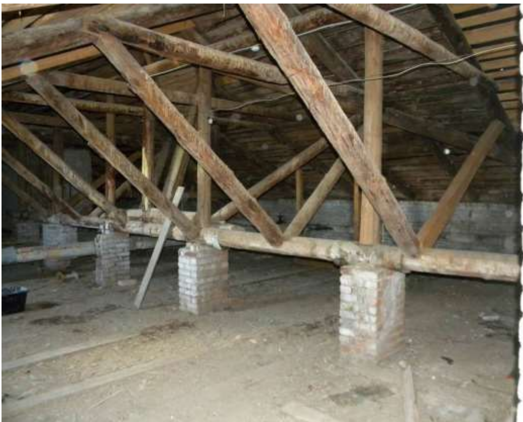
Фото №23 - Общий вид конструкций крыши
