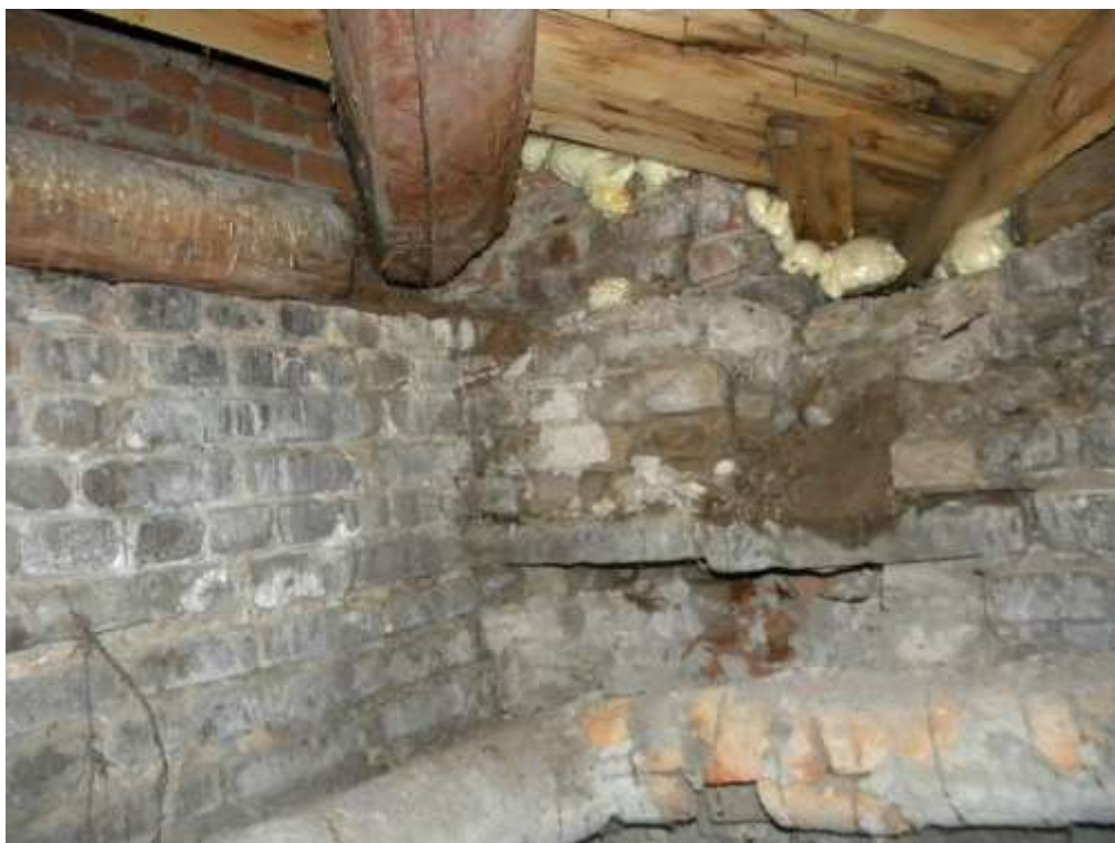
Фото №21 – Разрушение перемычки из прутков арматуры над оконным проемом
