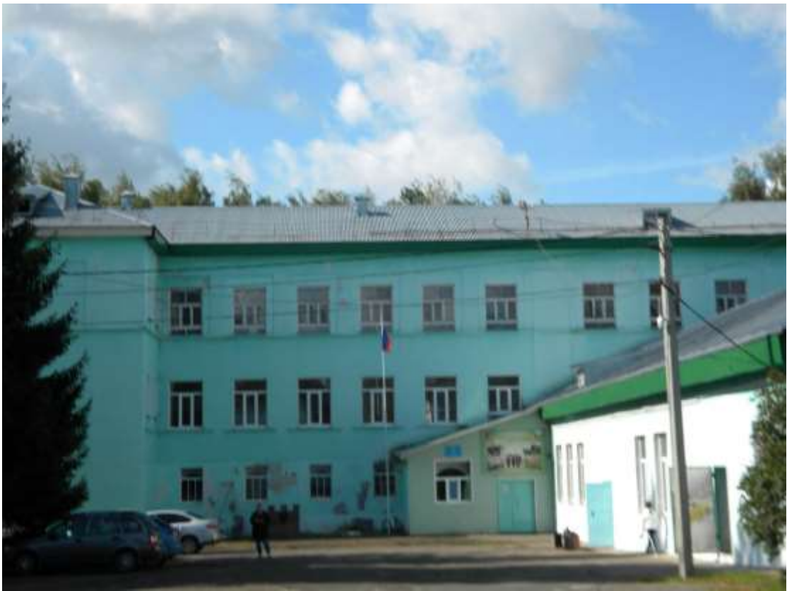
Фото №1 - Общий вид крыши
