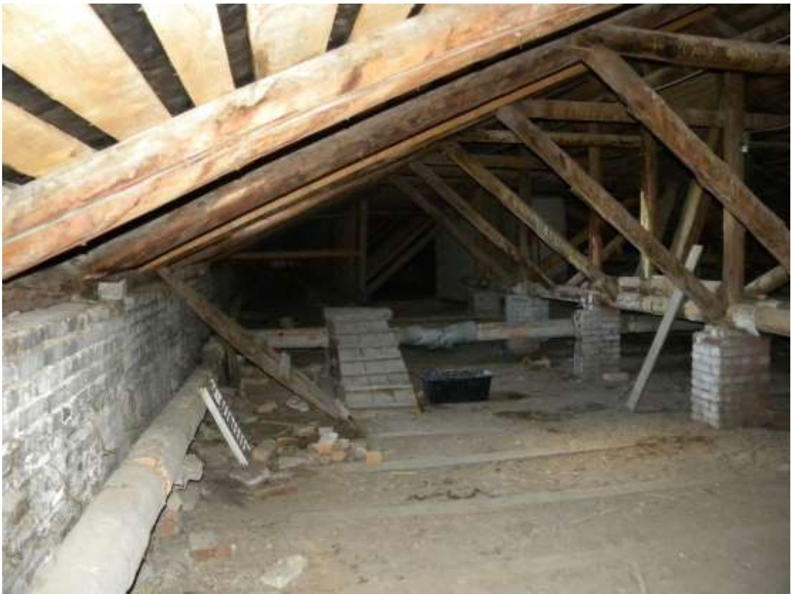
Фото №22 - Общий вид конструкций крыши
