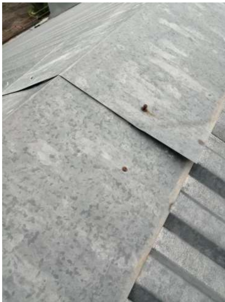
Фото №17 – Крепление конькового элемента гвоздями!!!
