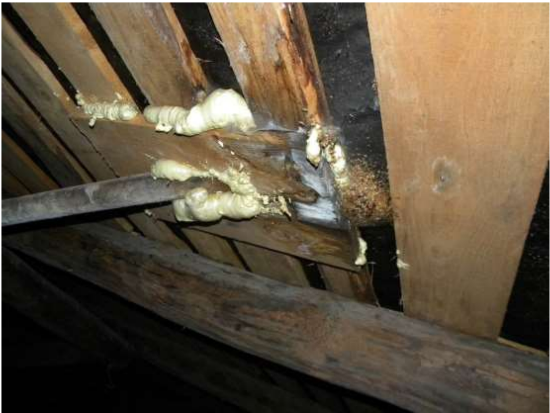
Фото №30 – Проход через кровлю инженерных коммуникаций
