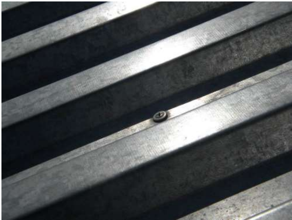
Фото №16 - Крепление покрытия обычными саморезами с пресс-шайбой!!!
